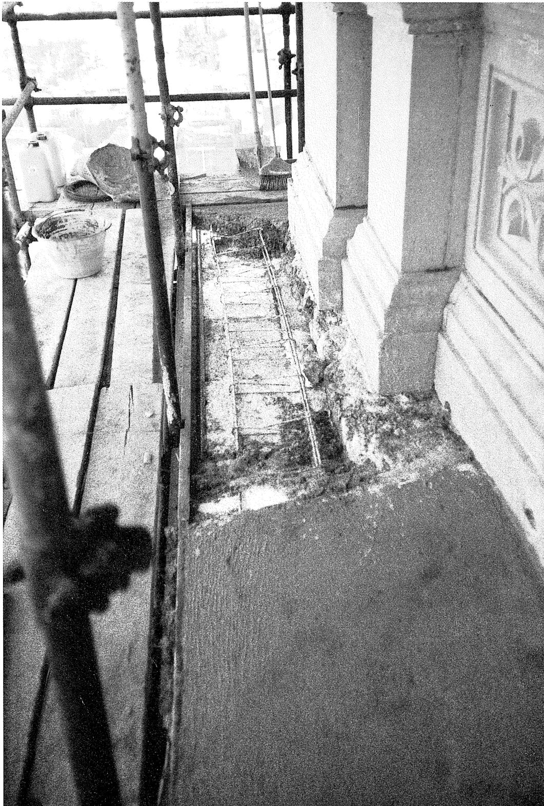
**Ripristino dei cornicioni con posa in opera di armatura metallica, getto e formazione di pendenza con malta epossidica.**
