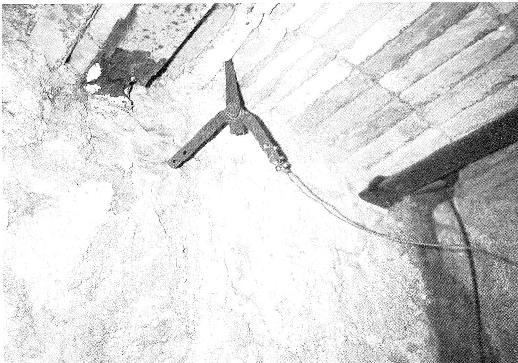
**Corrosione in corrispondenza degli appoggi delle travi metalliche a sostegno del solaio della cella campanaria.**
